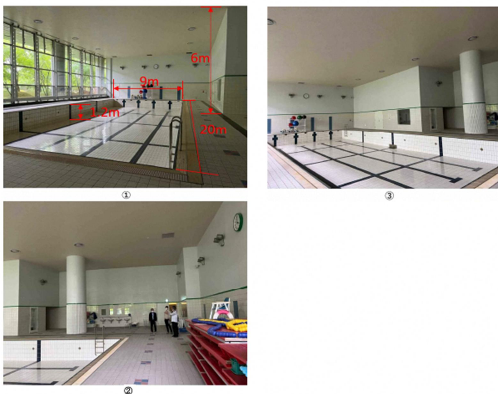
【図表134 温水プールの状況】
