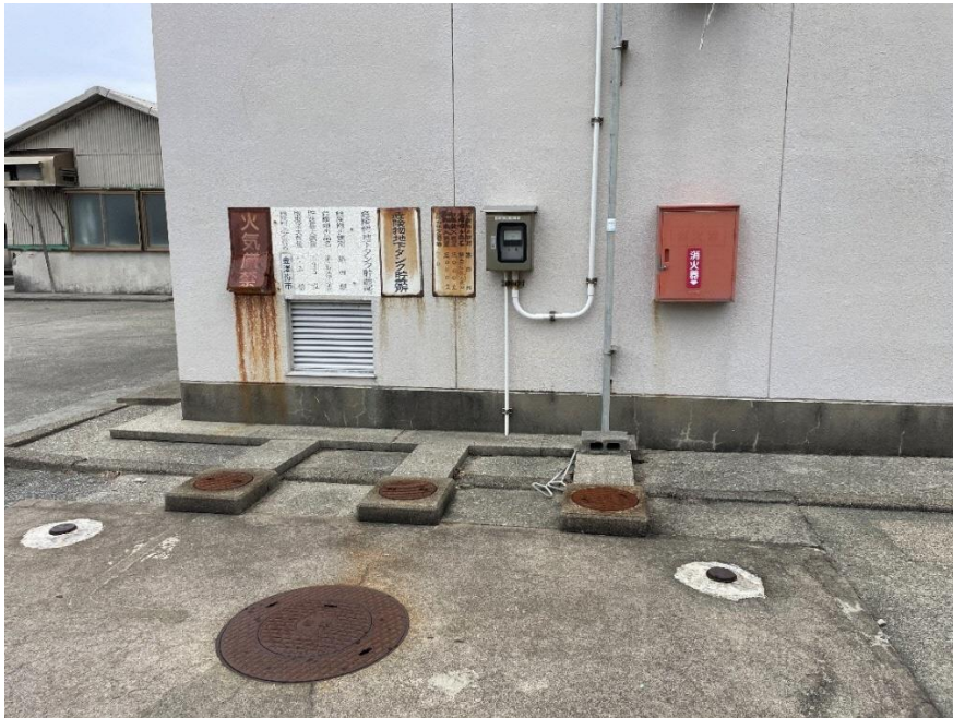
使用していない地下タンク
