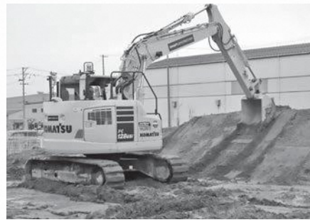
ICT建機による施工
