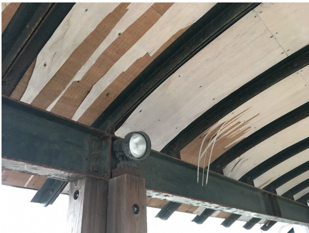
図2 コロネード通路内部
