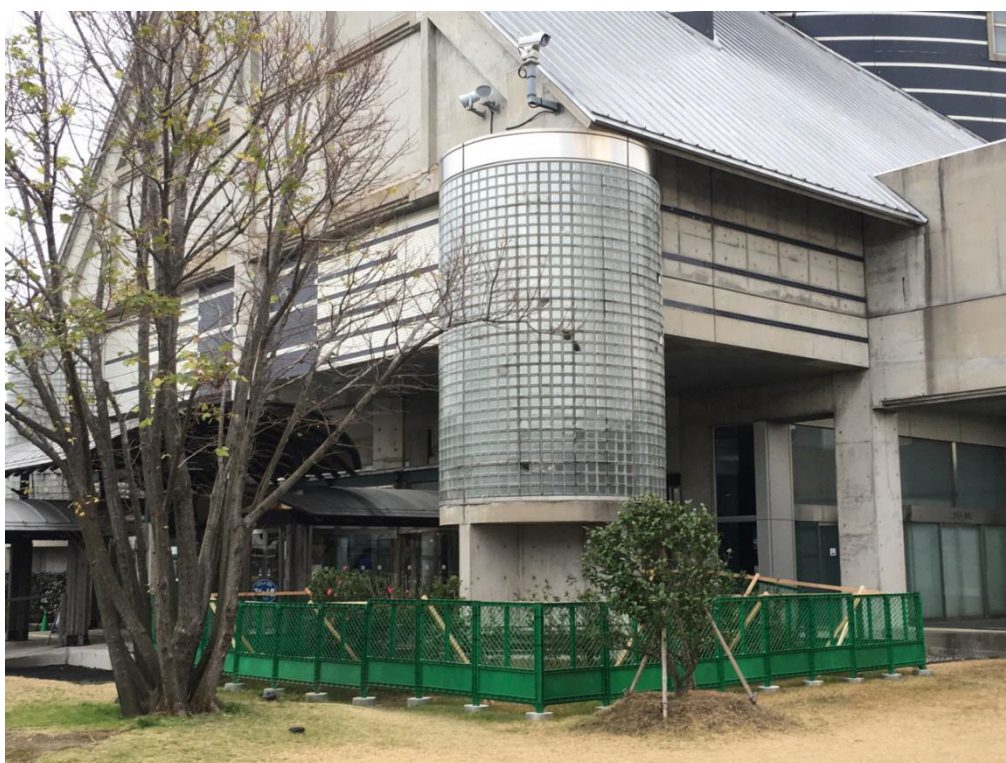
図4 アピール館（ガラススタイルの破損）
