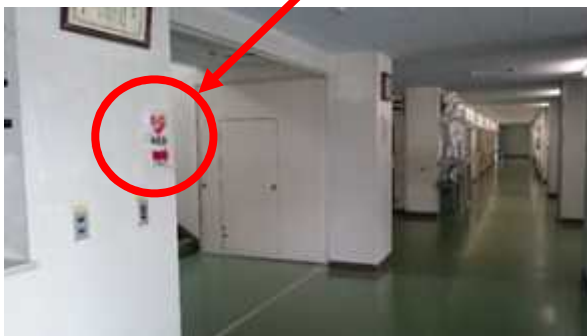
廊下にAED設置方向を示す表示
