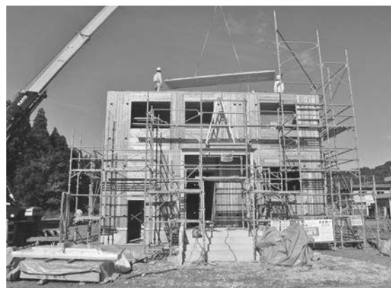
CLT工法による建築工事
