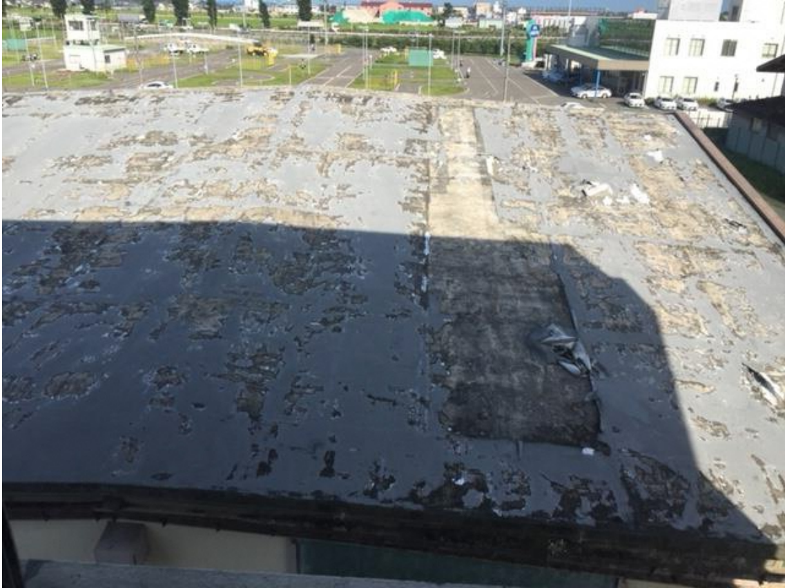
写真①(3号館屋上の状況)
